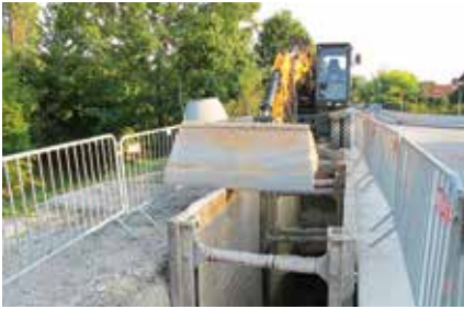
Laufende Erneuerungen beim Kanal
