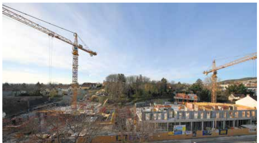
Auch beim Tremmelhof geht es zügig voran.
