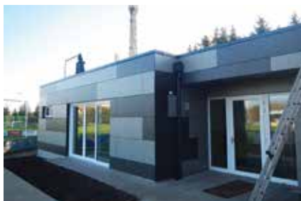
Der Zu- und Umbau des Sportplatzes ist schon fast fertig
